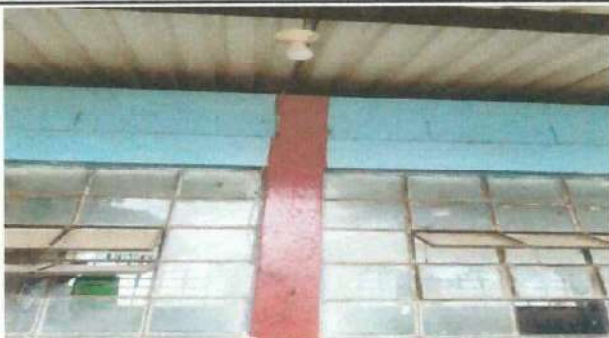
Foto 9: Instalación formal de energía eléctrica en las aulas y corredor.
