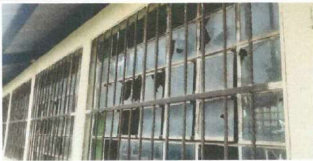
Foto 3: Instalación de 14 balcones de metal.
