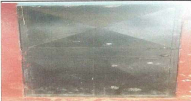
Foto1: Cambio de tres puertas de metal
