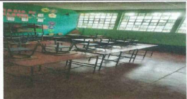
Foto 4: Instalación de cerámica de 2 aulas y corredor.
