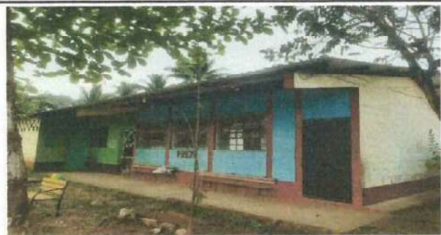
Foto 6: Pintura interior y exterior de aulas bodega y baños.
