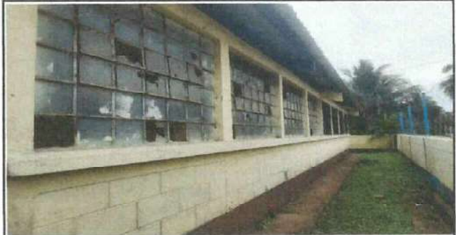
Foto 2: Cambio total de 14 ventanas a PVC
