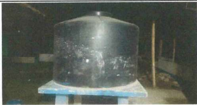
Foto7: Cambio de tinaco por deterioro y antigüedad
